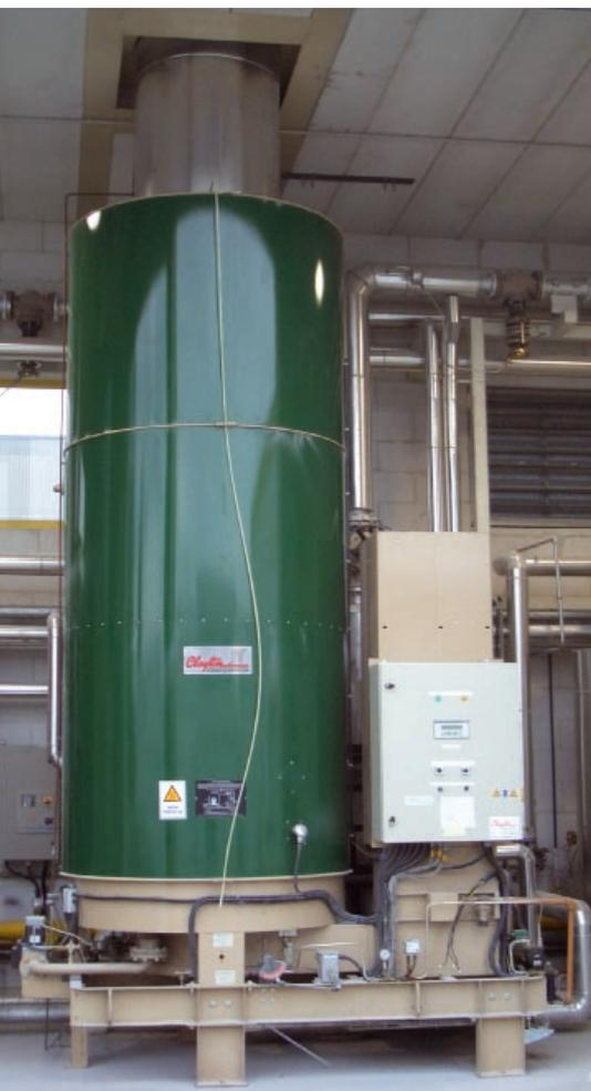
Abb. 1: Der 15t/h Schnelldampferzeuger von Clayton liefert 15 t Dampf pro Stunde.
